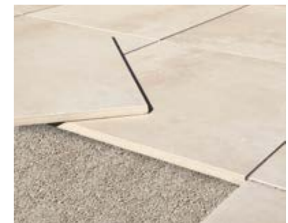
POSE SUR GRAVIER ET SABLE / VERLEGUNG AUF KIES UND SAND
